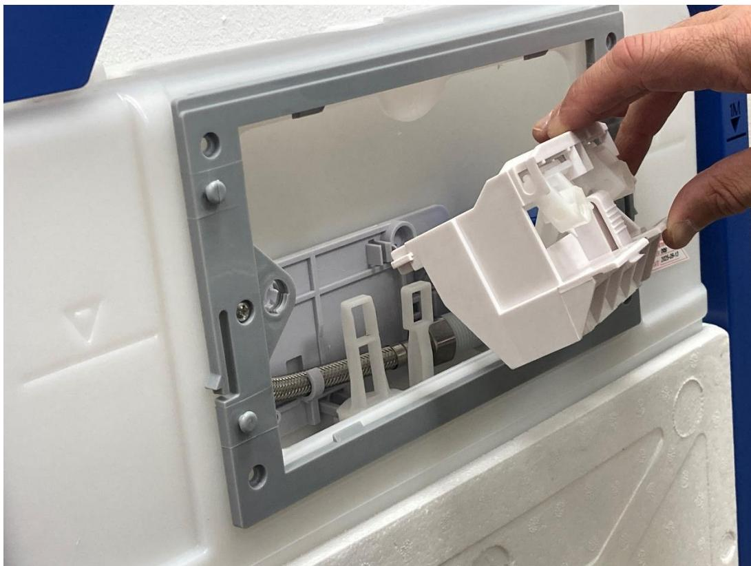
4. Возьмите сливной механизм с сервоприводом и датчиком движения
