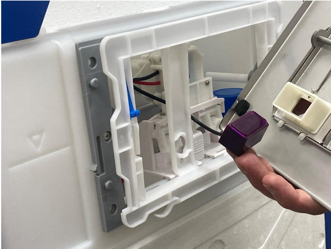
12. Установите кнопку с датчиком на инсталляцию (после окончания отделочных работ в помещении)
