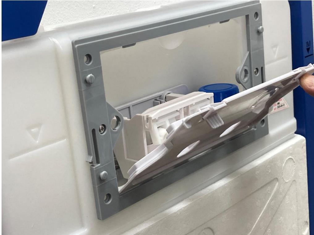
2. Нажав на защелку выньте часть сливного механизма
