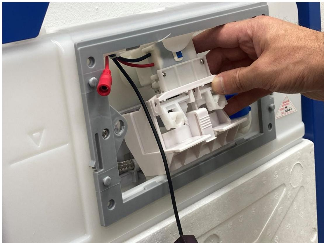
6. В корпусе сливного бака в верхней части сделайте небольшое отверстие и выведите в него провод питания сервопривода
