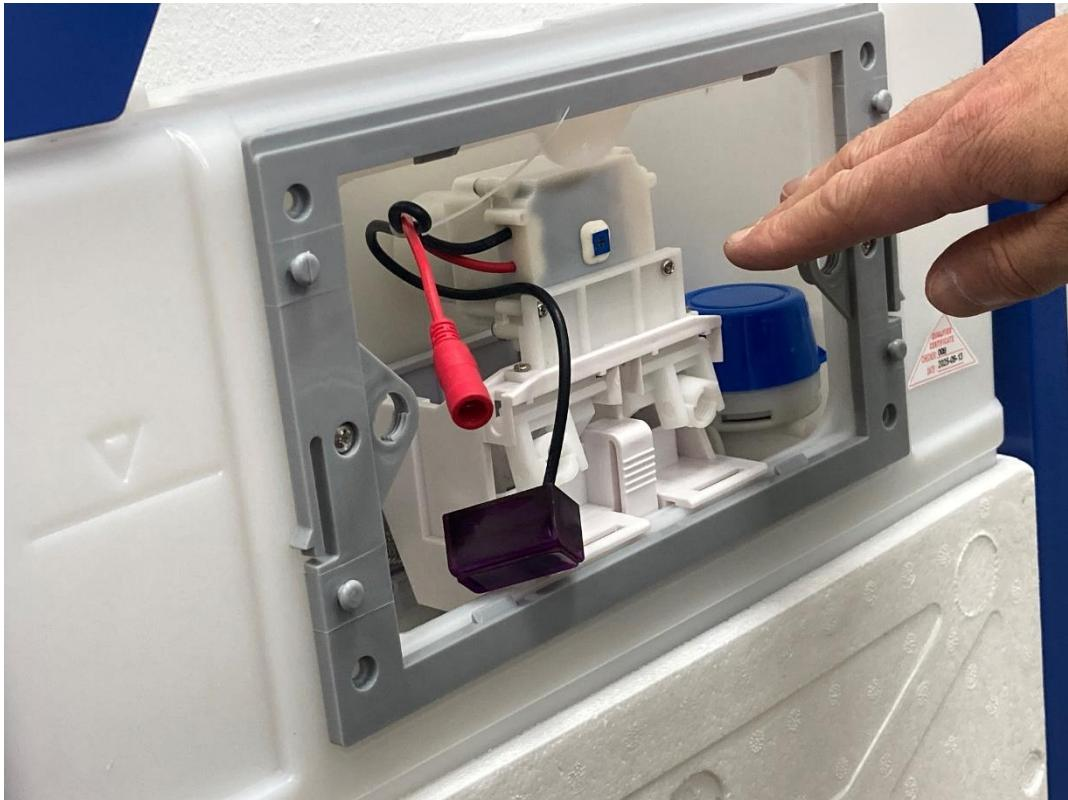
7. Для удобства используйте удлинительный провод, который соединит сервопривод и блок питания
