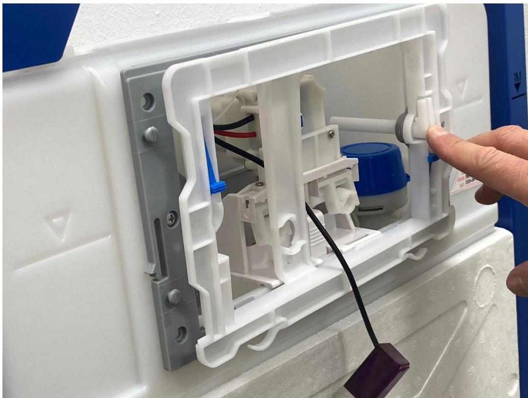
10.2 Используя специальные "Г" образные установочные болты, закрепите рамку на инсталляции (производится после окончательного монтажа инсталляции и завершения отделочных работ)
